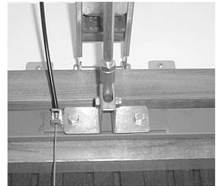
Die serienmäßige Torverriegelung muss außer Funktion gesetzt werden. Das Getriebe des Torantriebes verriegelt das Tor automatisch. Sollte jedoch zusätzlich eine Verriegelung (Bodenschnäpper) gewünscht werden, fragen Sie bitte Ihren Fachhändler.
