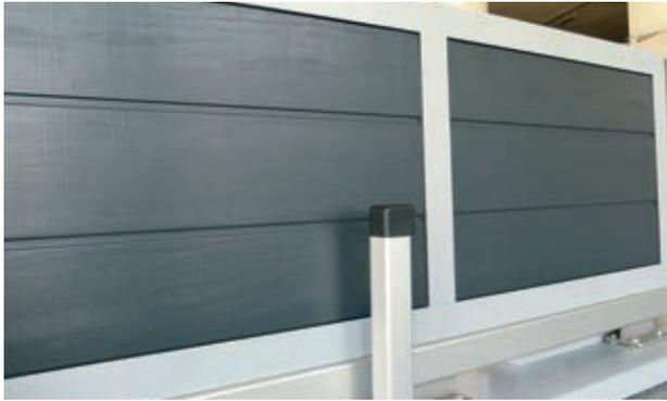
Der Stahlrahmen eines Alpha-Tores ist durch Feuerverzinkung im Tauchbad bestens gegen Korrosion geschützt. Diese Technik ist anderen Verzinkungsmethoden deutlich überlegen.
